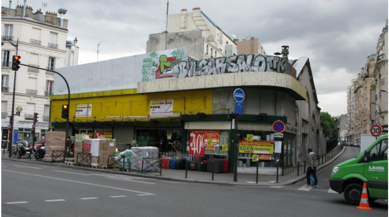
2014, mit subjazent vorangesetzten Adsystemen (inzwischen entfernt)
